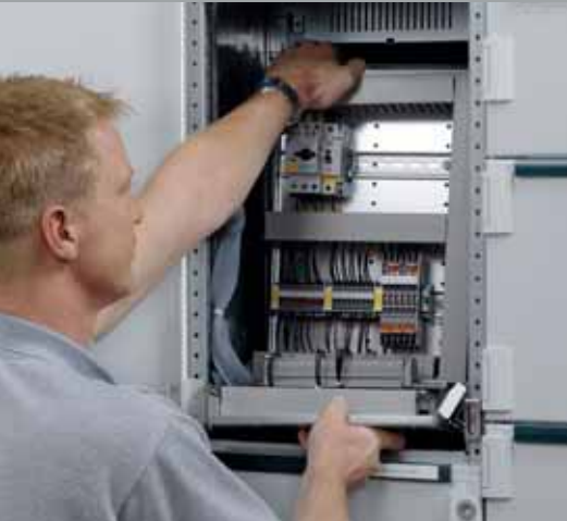
Съемная плата со вспомогательными аппаратами
