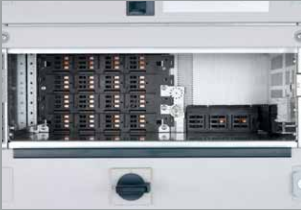
Заднее расположение системы втычных шин в отсеке
